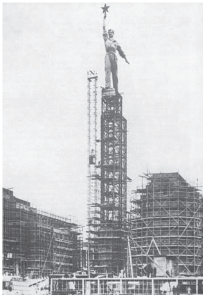
Павильон СССР в процессе монтажа. Нью-Йорк, 1939 г.
