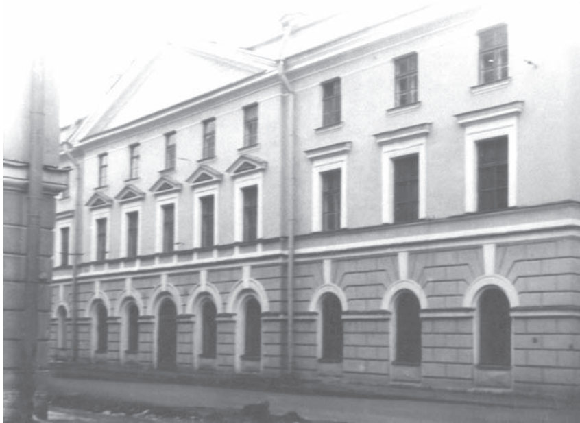
Казармы Конногвардейского полка. Арх. И. Черник
