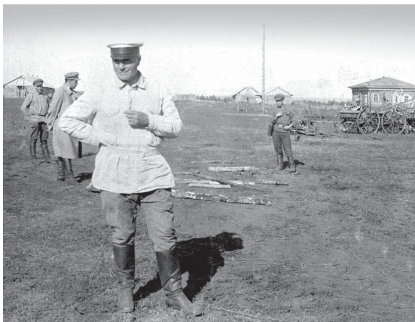
На землеустроительных работах
