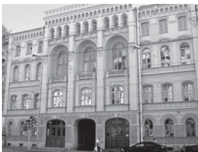
Литейный, 44. Фасад здания
