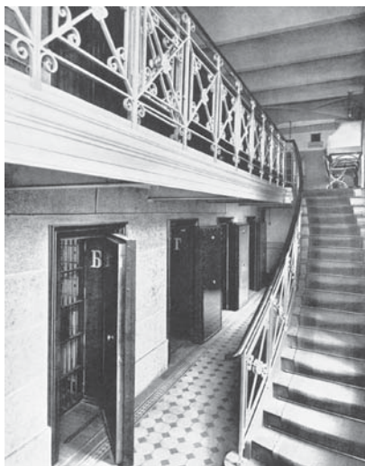
Лестница в кладовую безопасных ящиков хранения
