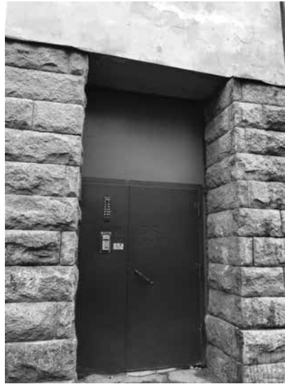
Примеры замены исторических деревянных дверей парадных на металлические
