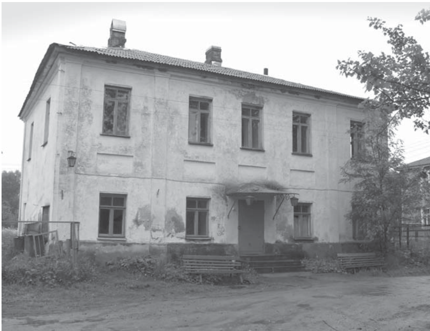
Кобона. Здание бывшего караульного помещения Ладожского канального батальона
