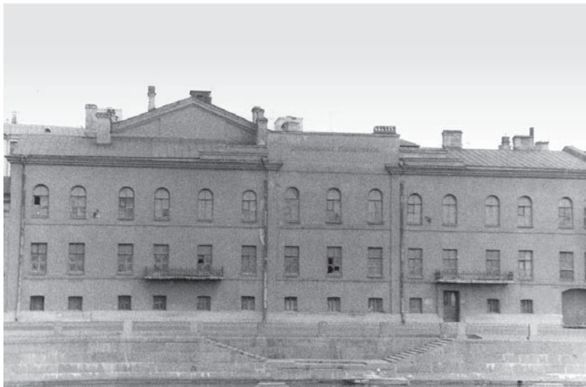
Подготовленное к ремонту здание библиотеки. 1973 г. Архив ЦГПБ им. В. В. Маяковского
